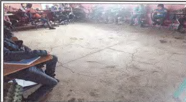
Foto 6: Estado actual piso de torta del aula de Quinto grado primaria sección A, de 6.90 mts. de largo por 5.75 mts de ancho, igua la 39.675, se aproximó a 40 mts. Cuadrados
