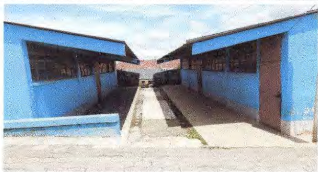
Foto 1: Estado actual, del techo de espacio entre las dos aulas
