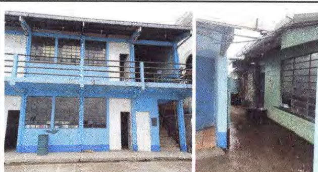
Foto 8: Estado actual de los tubos PVC 3"
