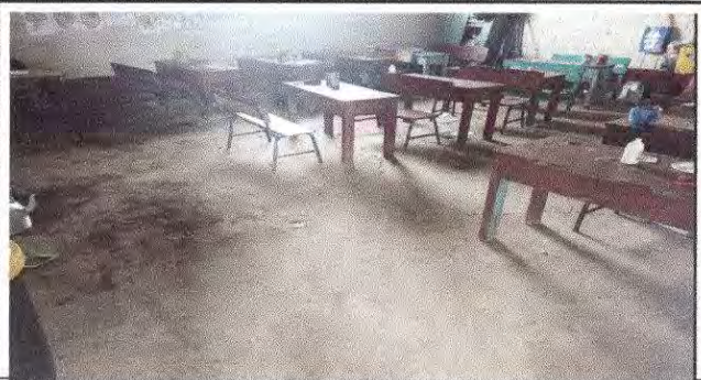
Foto 5: Estado actual piso de torta del aula de Pre-primaria Bilingüe, de 6.90 mts. de largo por 5.75 mts de ancho, igua la 39.675, se aproximó a 40 mts. Cuadrados
